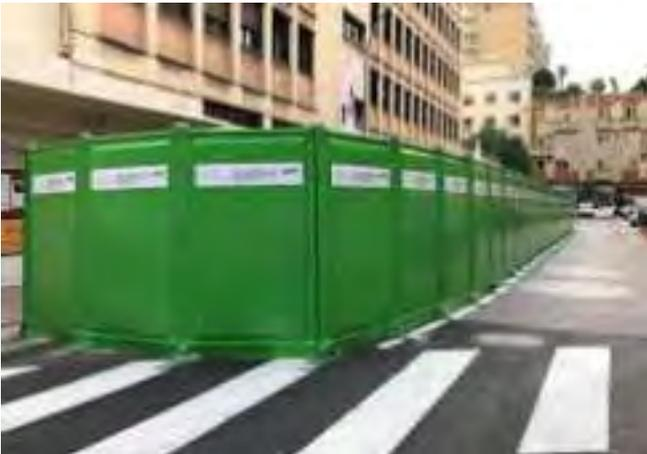
*Figura 8 - esempio barriera mobile da cantiere*
